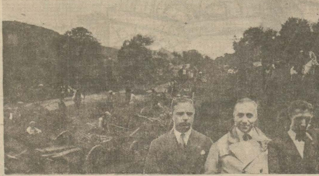
Bartında geni yol inşaatından bir intiba ve muhabirimiz
